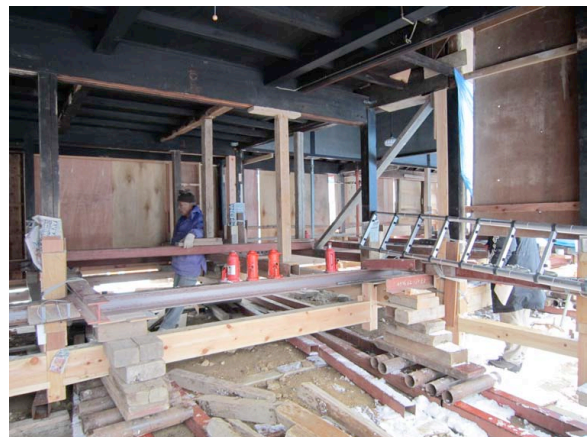
曳屋の根がらみとコロの設置状況
