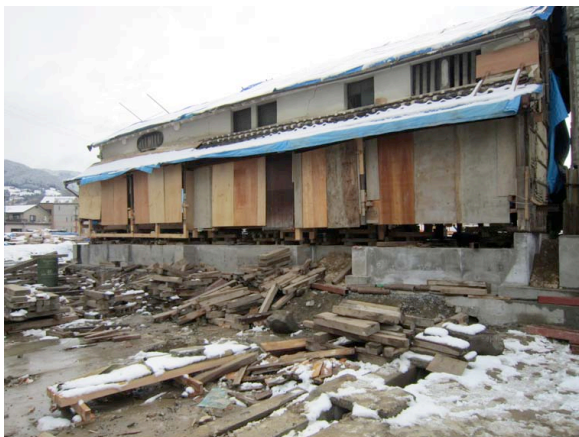
曳屋され新しい RC 造基礎にのる主屋
