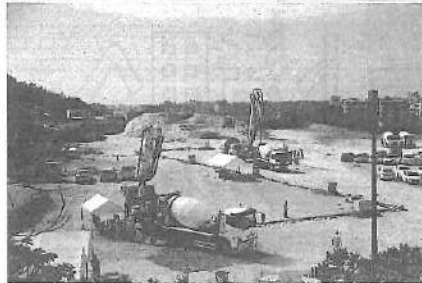
圧送後のコンクリートの性状も確認した
